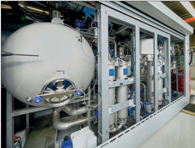
Die Lösemittel tanks befinden sich auf der Rückseite der Reinigungsanlage «EcoCore» von Ecoclean.
